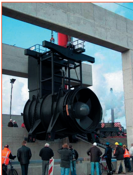
Проект «Морская дамба»: 7 насосов производительностью 40 м 3 /сек каждый
